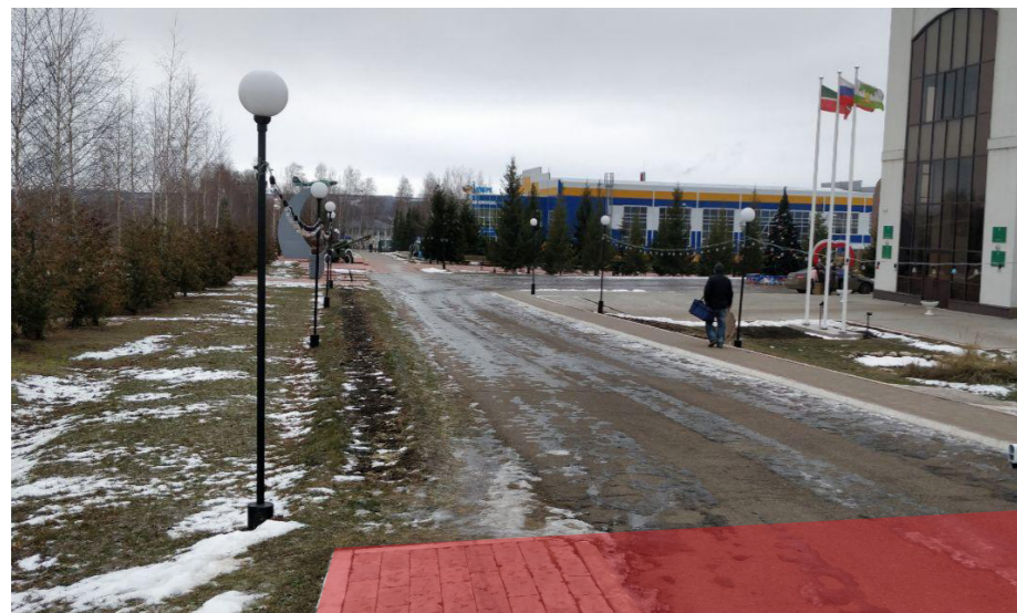
Отсутствие входной группы
